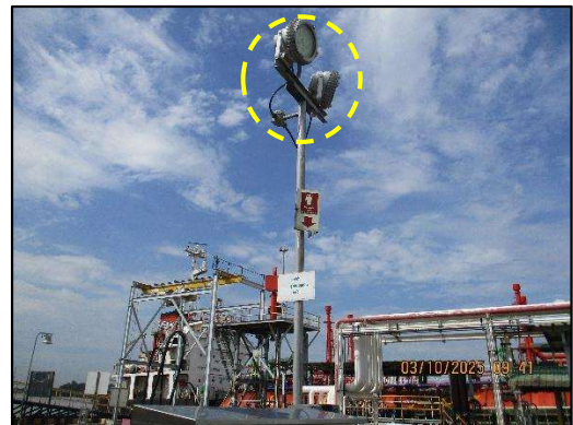
ภาพถ่ายที่ 2.2-9 ไฟแสดงขอบเขตท่าเทียบเรือ และไฟให้แสงสว่างบริเวณท่าเทียบเรือ
